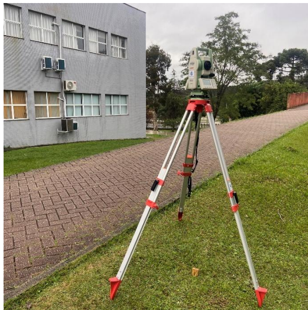
FIGURA 32 - INSTALAÇÃO DA ESTAÇÃO TOTAL
