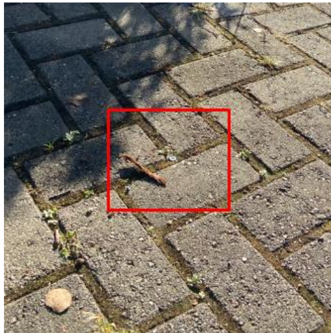
FIGURA 38 - PONTO MATERIALIZADO (PARAFUSO METÁLICO)
